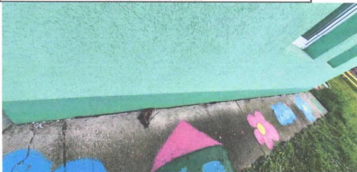
Neetanseitati ale trotuarului de garda – contrapanta + lipsa dop de bitum
