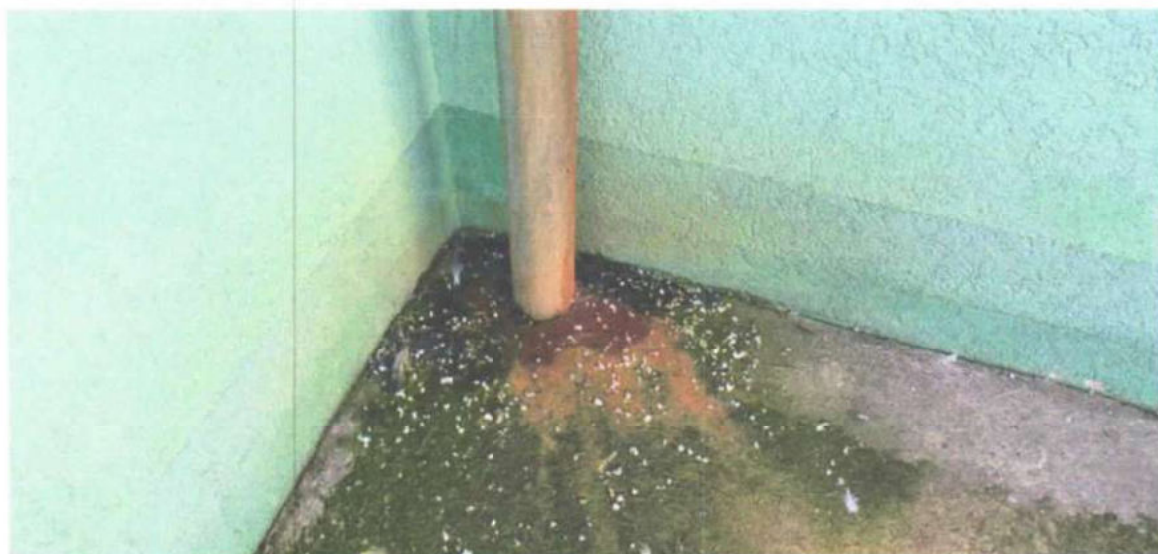
Neetanseitati ale trotuarului de garda – contrapanta + lipsa dop de bitum, prelingerea apei pe burlan
